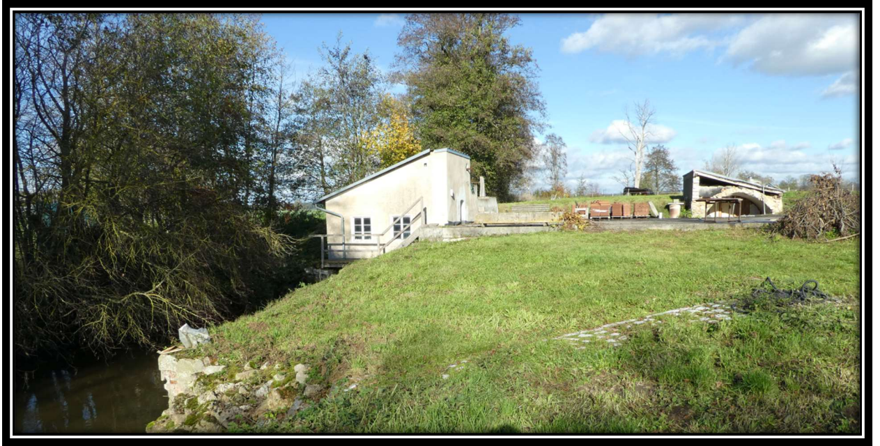
Das Areal der früheren Mühle. Foto Hopfenzitz, Nov. 2022. Stromerzeugung in dem wasserseitigen Turbinen-Häuschen
