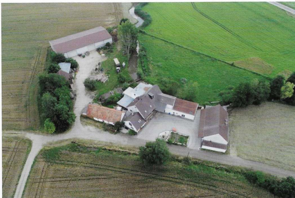
Die Obere Mühle Hs.-Nr. 69 am 14. Juli 2018 (Bild: Philip Baumann).
